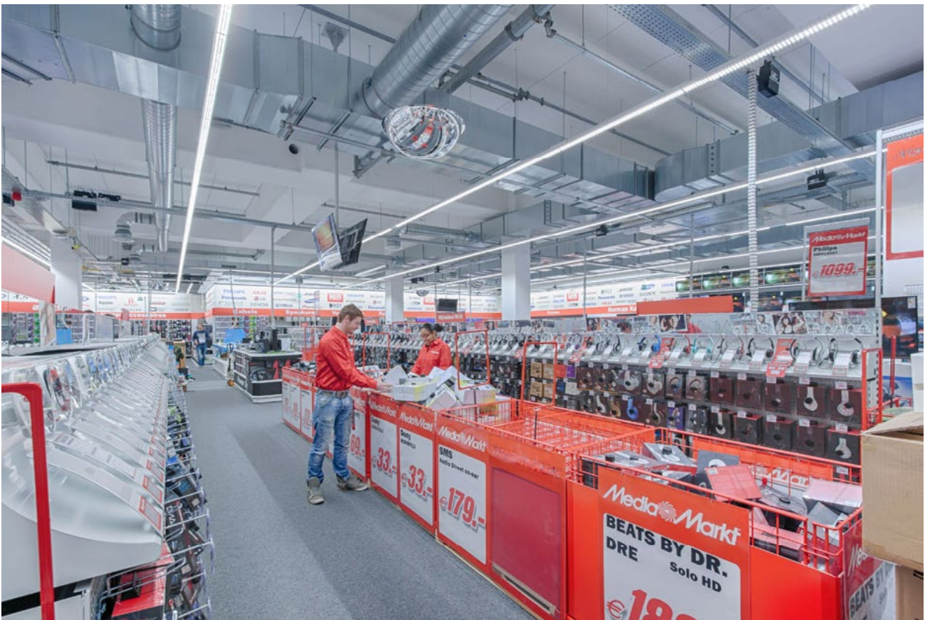
Media Markt in Assen heeft LED-verlichting met een geïnstalleerd verlichtingsvermogen van 6,2 W/m 2 .
