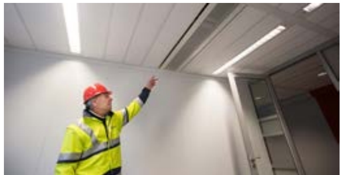
Ministerie Den Haag. 11.000 armaturen zijn hergebruikt en voorzien van HF verlichting.
