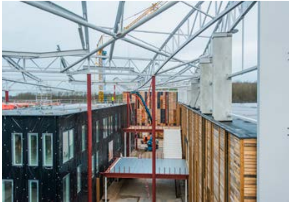
Hoofdkantoor Alliander Duiven. Ruim 80% van al het materiaal is hergebruikt.
